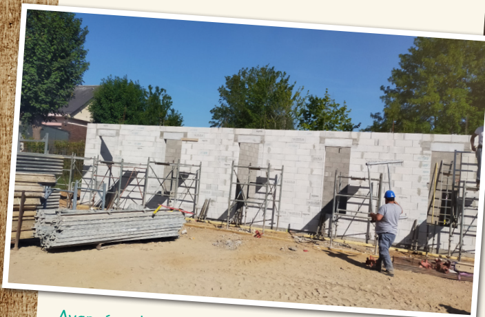
Avancée des travaux de la Maison de Santé Pluridisciplinaire avec le coulage de la dalle du bâtiment et l'élévation des différents murs.
