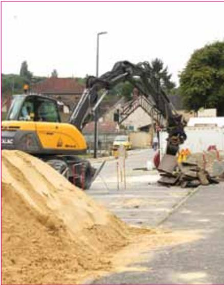
L'**effacement des réseaux de la rue Grégoire** a débuté le 13 septembre : suppression de l'ensemble des câbles aériens et des poteaux des réseaux électrique et téléphonique. Les candélabres existants seront aussi remplacés. Les travaux de terrassement sont prévus pour une durée de 4 semaines. Ils seront suivis par la mise en place des câbles souterrains et basculage des réseaux. La fin du chantier est prévue vers la mi-novembre (hors réseau téléphonique).
